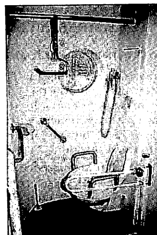
Fig. 3. - Aménagement de WC (rehausse siège avec appuis latéraux ; différents types de barres d'appui ; pince à papier toilette ; adaptation de commande de chasse d'eau).
