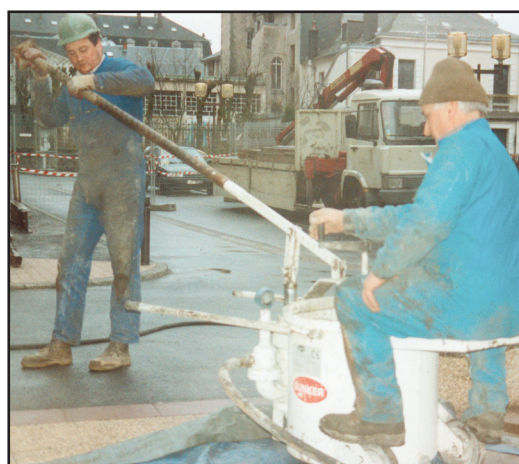
(E) Machine à fabriquer et injecter du laitier en faible quantité.
