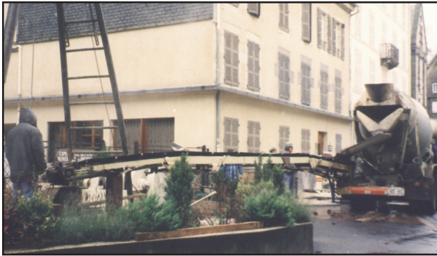
(A) La pouzzolane, amenée par des toupies est injectée dans les puits par tapis roulant.
