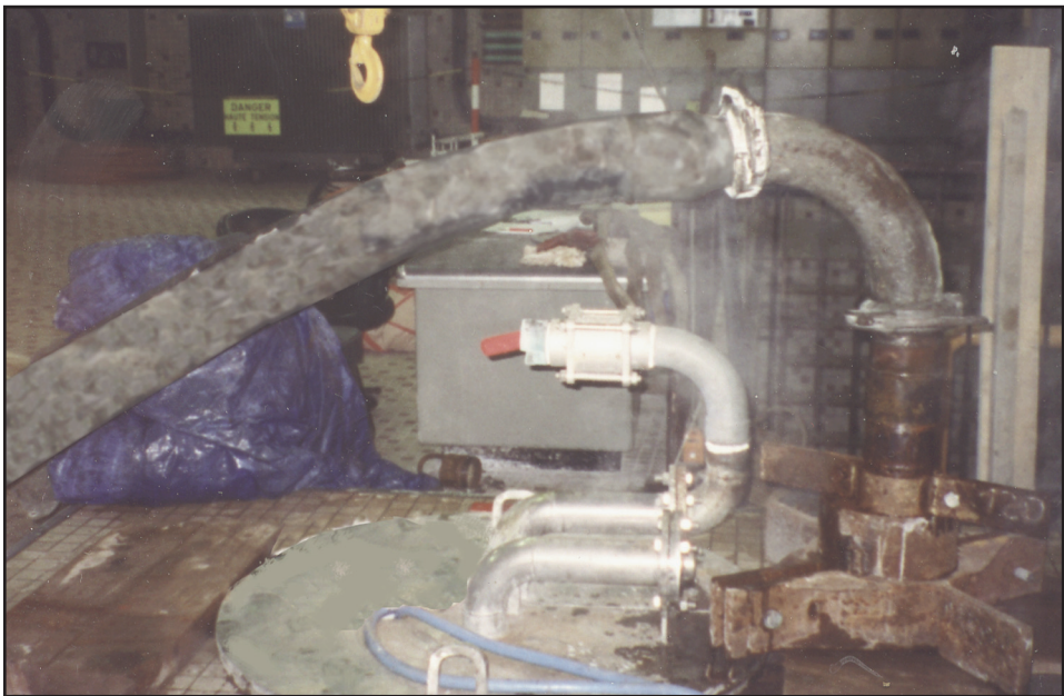
(E) Sommet de la canne d'injection de grand diamètre du béton.
