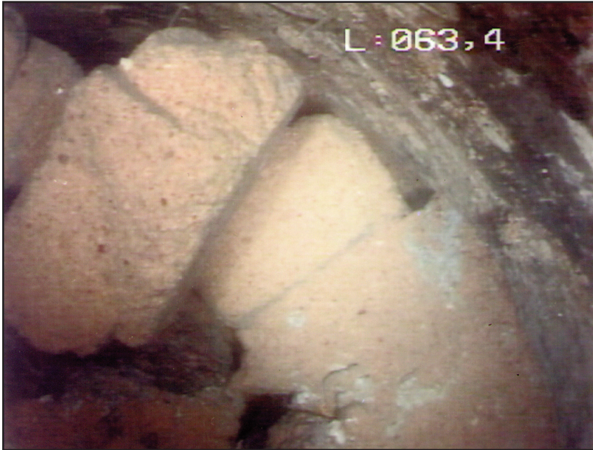
Figure 9 - Parement de brique dégagé par air-lift au fond du forage Choussy 2.
