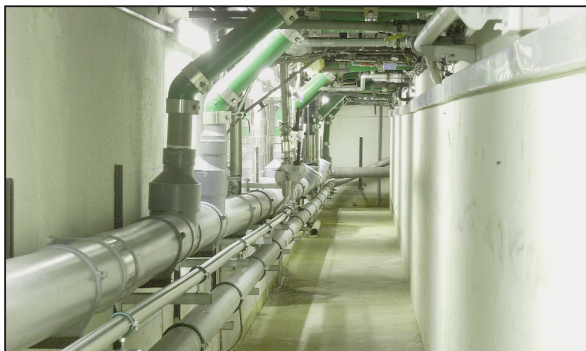
Figure 12 - Equipements des trois canalisations amenant l'eau géothermale vers les trois établissements : Grands Thermes, Résidence thermique et climatique (R.T.C.) et Choussy. A : point de prélèvement ; B : vanne de fermeture ; C : manchette transparente ; D : compteur volumétrique.
