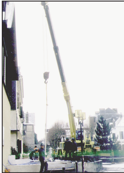
(A) Puits Perrière : extraction d'un élément de pompe.
