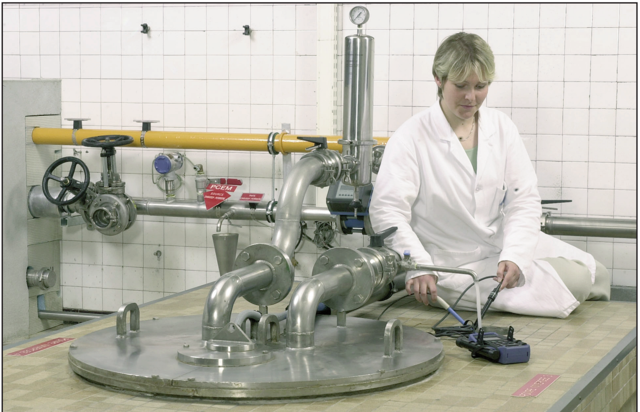
Figure 2 - Mesures de paramètres physico-chimiques en tête de puits Choussy 2
