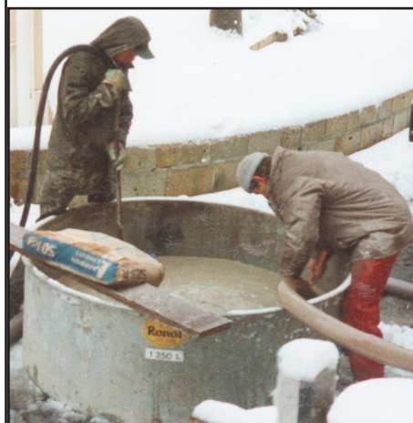
(C) Fabrication du laitier de faible densité.
