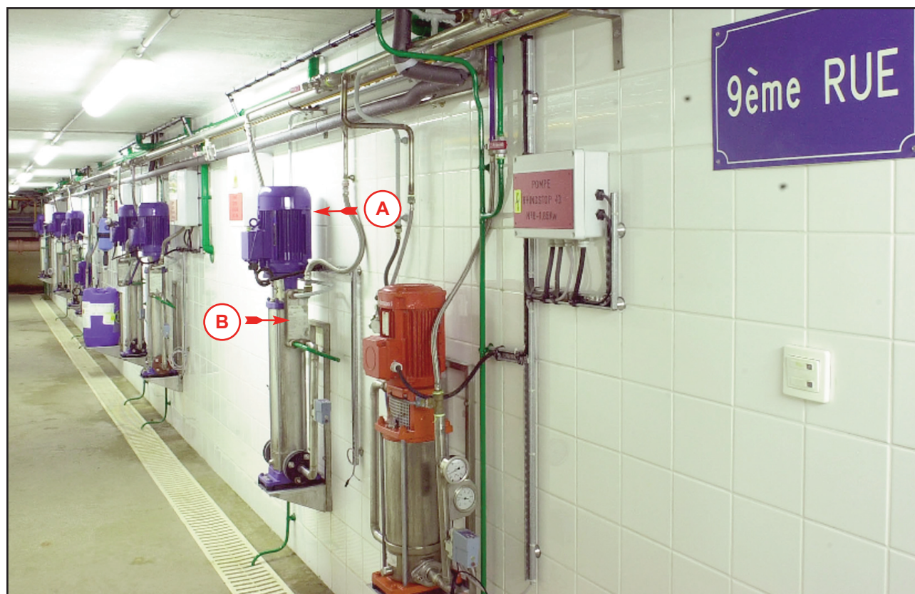
Figure 18 - Sous-sol des Grands Thermes, 9ème rue. Equipements complémentaires pour les douches filiformes. A : surpresseurs. B : échangeur de chaleur.
