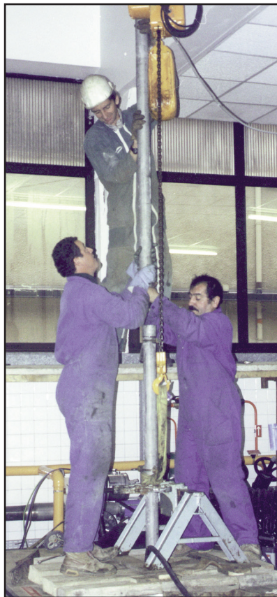
(C) Descente de la colonne pour l'air-lift.
