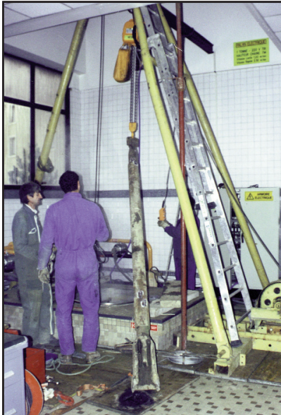
(A) Mise en place du trépan.
