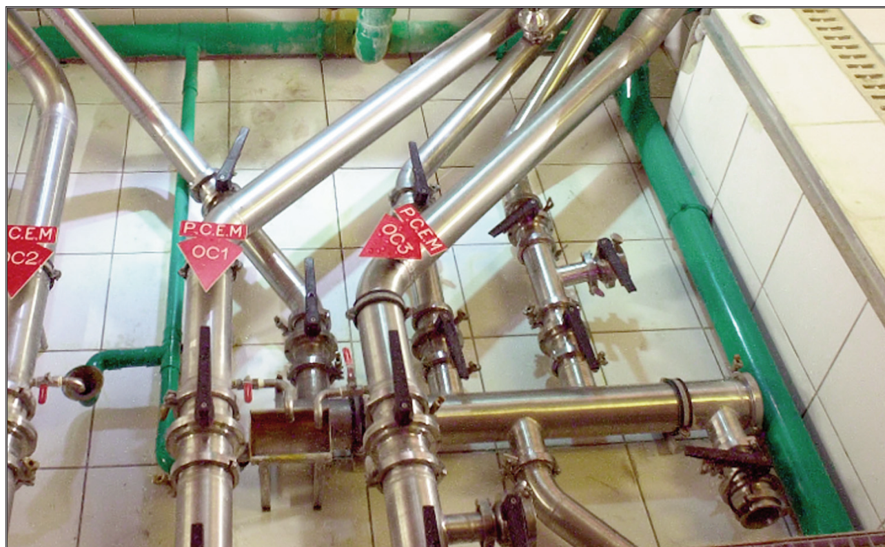
Figure 5 - Nourrice de distribution de l'eau géothermale vers les quatre réservoirs.
