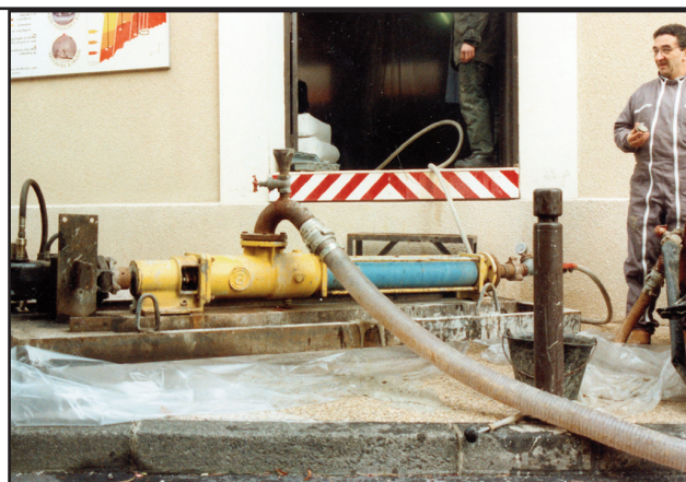
(B) Pompe d'injection du laitier de faible densité.
