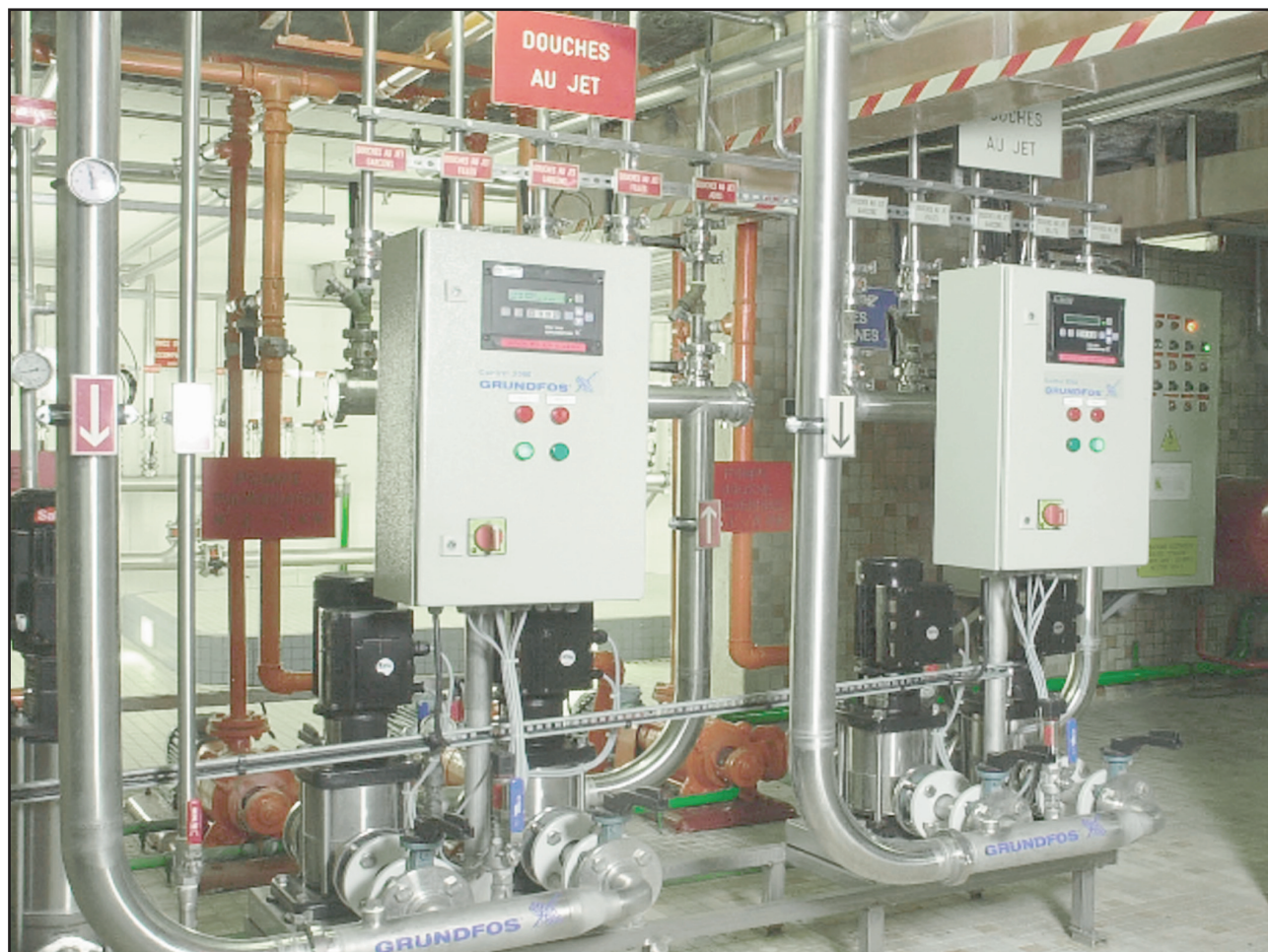
Figure 17 - Sous-sol des Grands Thermes, salle Arvernes 2. Equipements complémentaires : surpresseurs pour les douches au jet.
