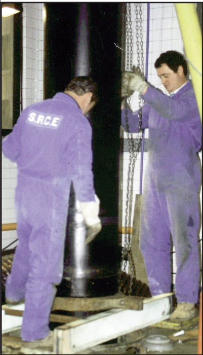
(D) Descente du tubage avec le palan à chaînes.
