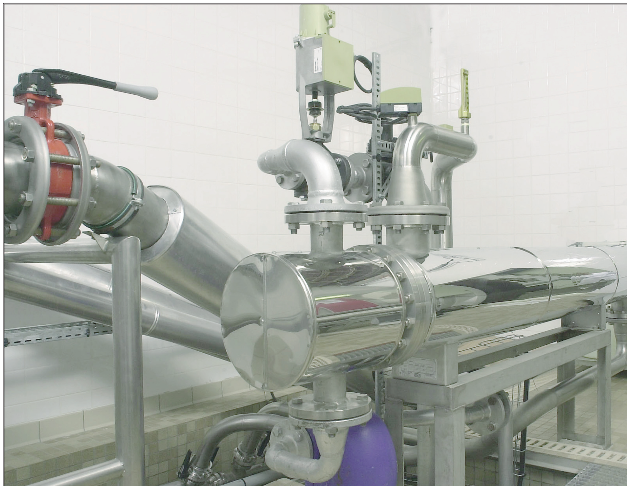
Figure 4 - Echangeur de chaleur permettant d'élever la température de l'eau du réseau de production à 70°C durant deux heures. L'énergie calorifique est fournie par une centrale de production de vapeur.
